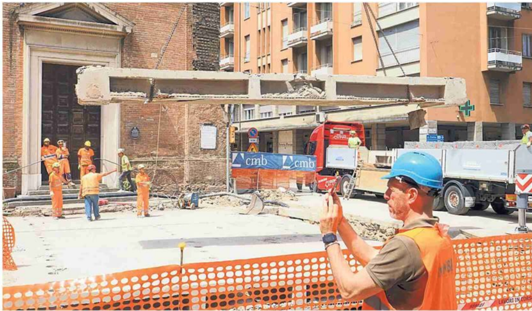
▲ La scopertura del Canale Reno: i lavori per la chiusura erano cominciati nel 1956
