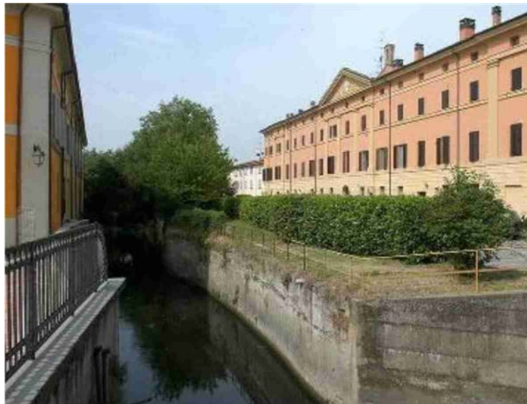
Un tratto del canale Navile che attraversa località Castello
