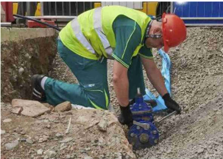
Un tecnico al lavoro su una condotta idrica in una foto d'archivio
