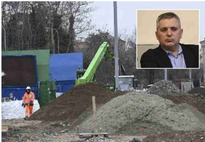
I lavori del Tram che devono terminare entro il 2026, in piccolo Nicola Stanzani
