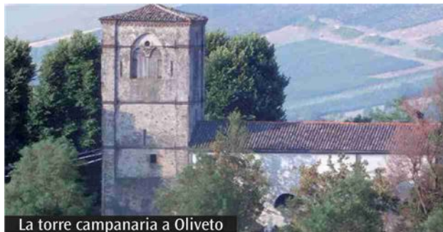
La torre campanaria a Oliveto
