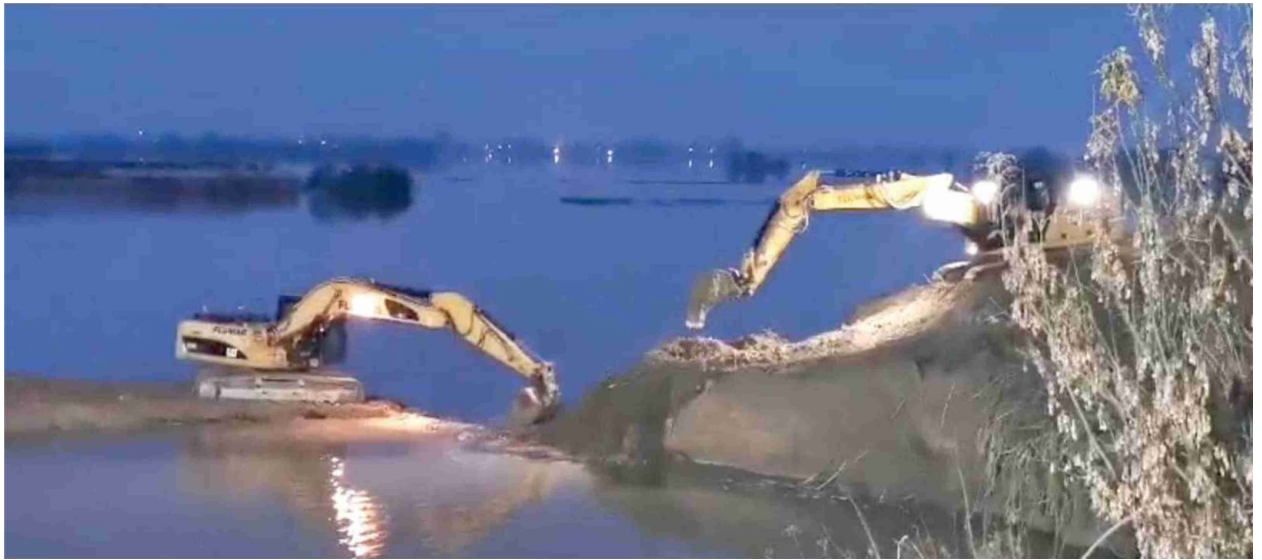
Le ruspe di Aipo e del Consorzio di Bonifica al lavoro per chiudere le falle degli argini nelle zone alluvionate
