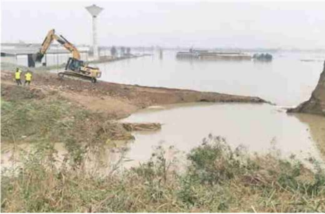
Le ruspe di Aipo e del Consorzio di Bonifica al lavoro per chiudere le falle degli argini nelle zone alluvionate
