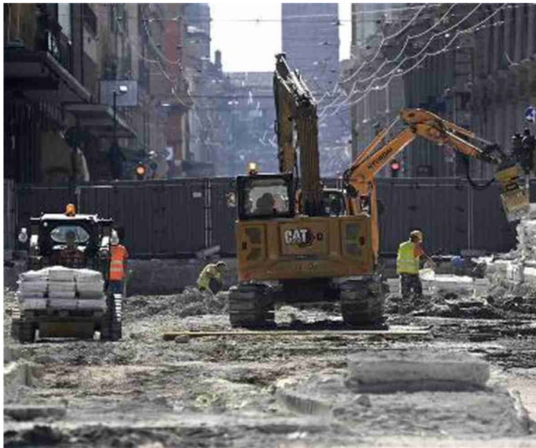
Durante il cantiere in via Ugo Bassi riaffiora la vecchia via Emilia
