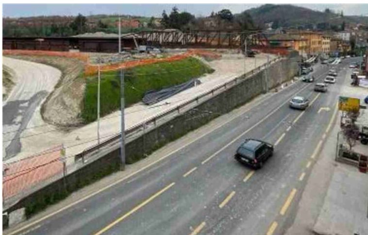
Il cantiere dei lavori per il Nodo di Rastignano
