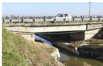
Il ponte sullo scolo consorziale 'Nuovo Tratturo'
