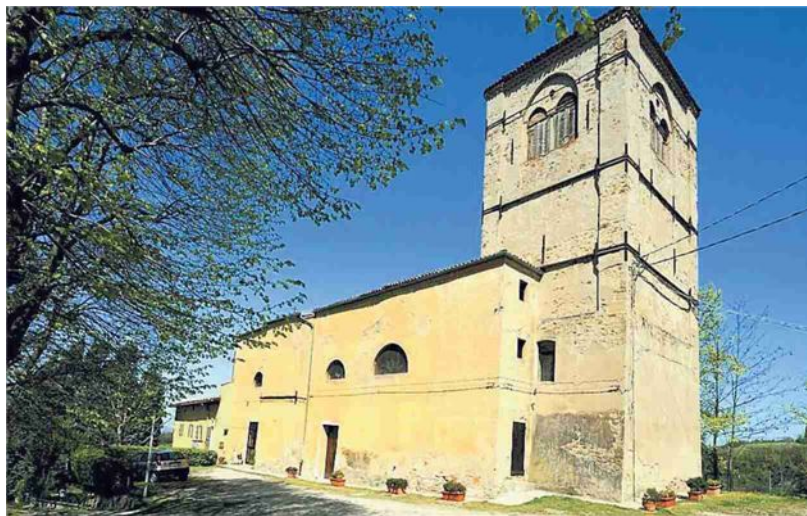
Il monumento La torre attigua alla chiesa di San Paolo a Oliveto
