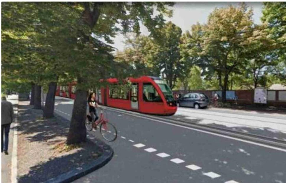
Un rendering del passaggio del tram in via di Corticella; qui la tranvia viaggerà su sede riservata sul lato est della carreggiata fino all'altezza dell'Ippodromo per poi proseguire in sede riservata e centrale fino al sottopasso della ferrovia
