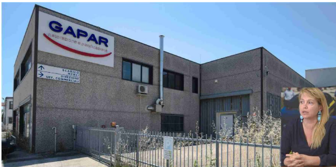
Sopra, l'ex sede della Gapar. Nel riquadro, il sostituto procuratore Lucrezia Ciriello FOTO FIORENTINI
