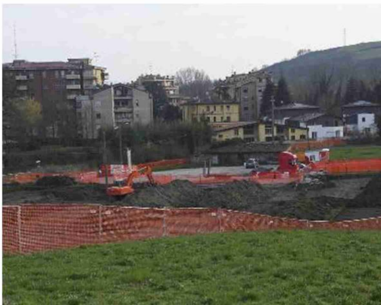
Il cantiere del nodo al Paleotto
