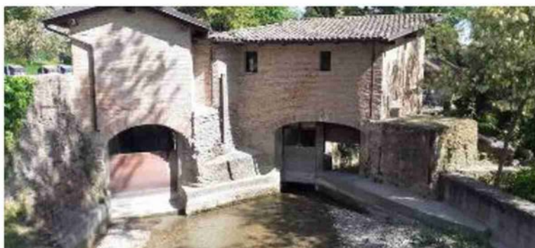
La chiusa medievale sul Sillaro a Castel San Pietro Terme, visitabile come quella di Bagnetto a Castello d'Argile e il Museo della Bonifica di Argenta
