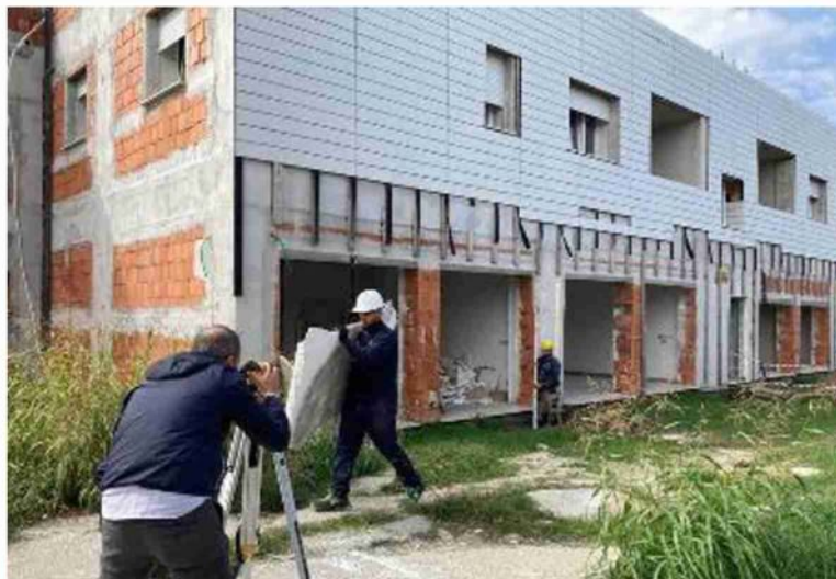
Operai impegnati nel cantiere per la costruzione della caserma
