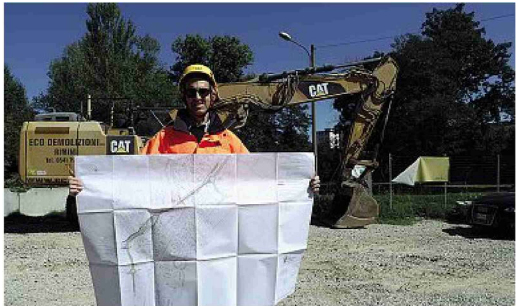
Cantieri Dopo decenni di attesa sono partiti i lavori per il secondo lotto del Nodo di Rastignano
