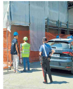
Un controllo in un cantiere edile
