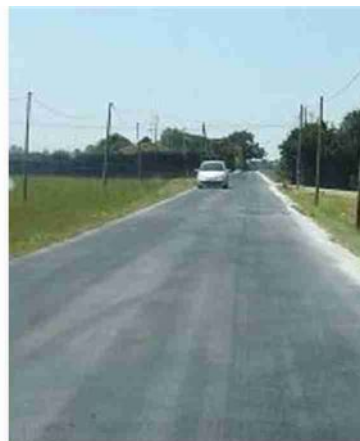
La strada prima e dopo i lavori: le crepe sono sparite
