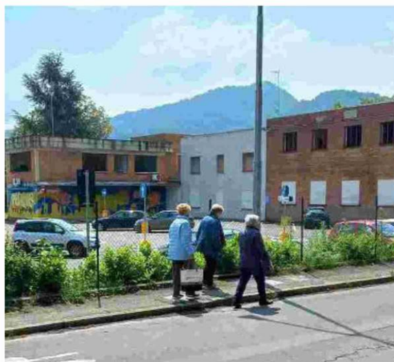
L'ex stabilimento Metalplast dove sorgerà la nuova scuola media di Sasso
