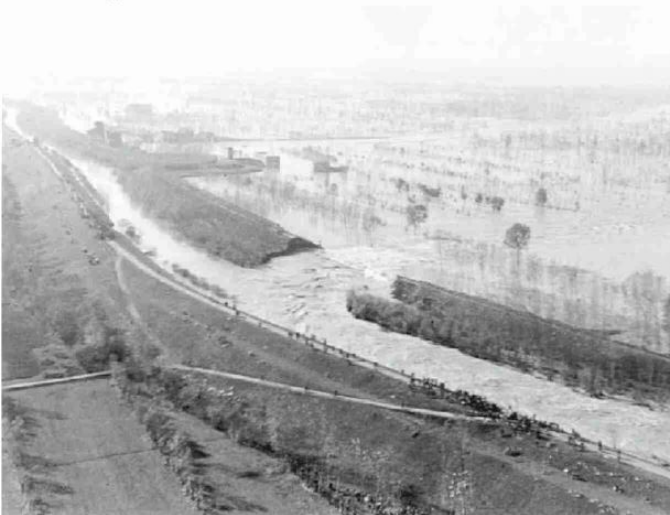
La rottura dell'argine da parte delle acque del torrente Crostolo
