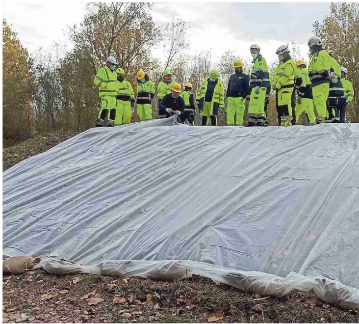
Una delle azioni più importanti in caso di piena: le operazioni di telonatura di un argine
