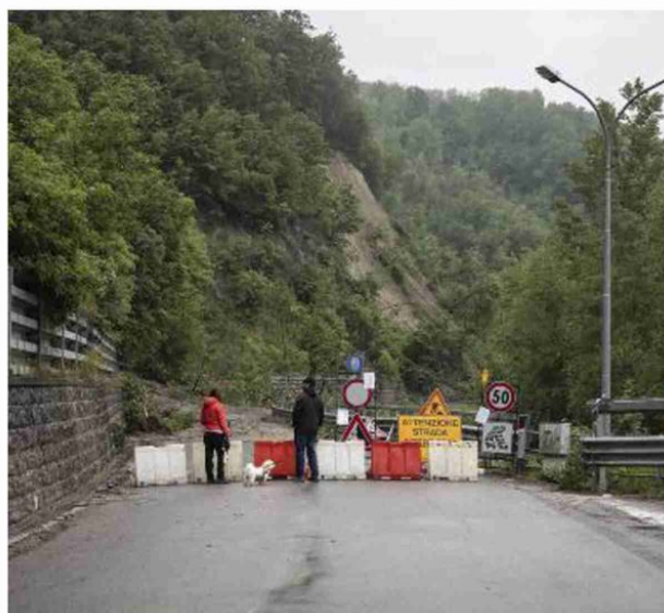
Monterenzio è spaccata in due da una frana provocata dall'alluvione di metà maggio
