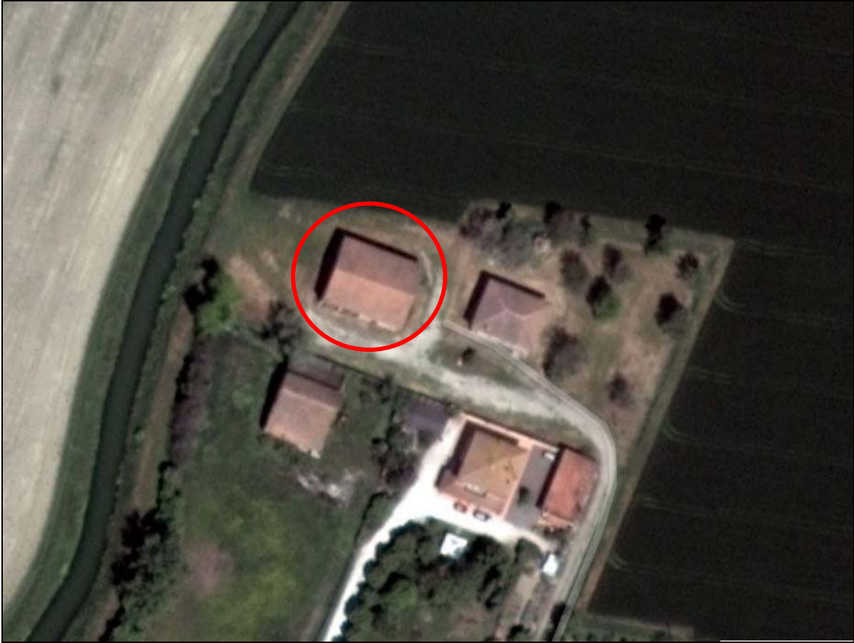
Particolare vista aerea dell'edificio da ricostruire
