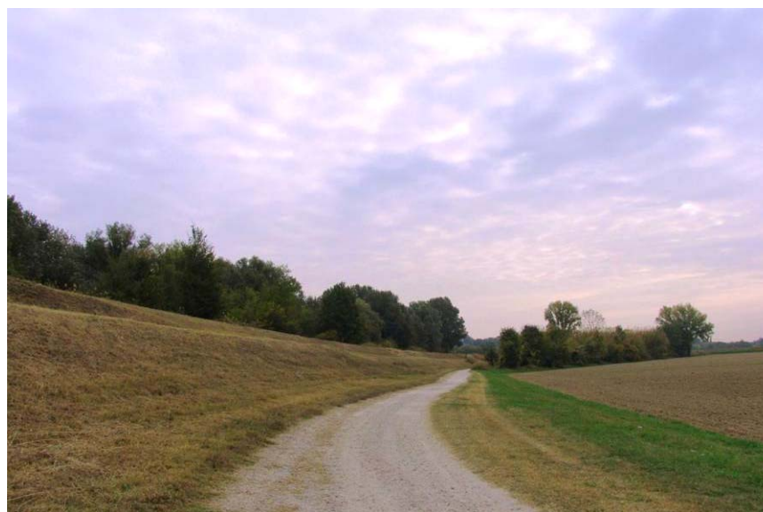
1/1- Cannocchiale visivo verso Nord e l'Area della Bisana; 2/1- Cannocchiale visivo verso Est, all'inizio della strada dell'area.
